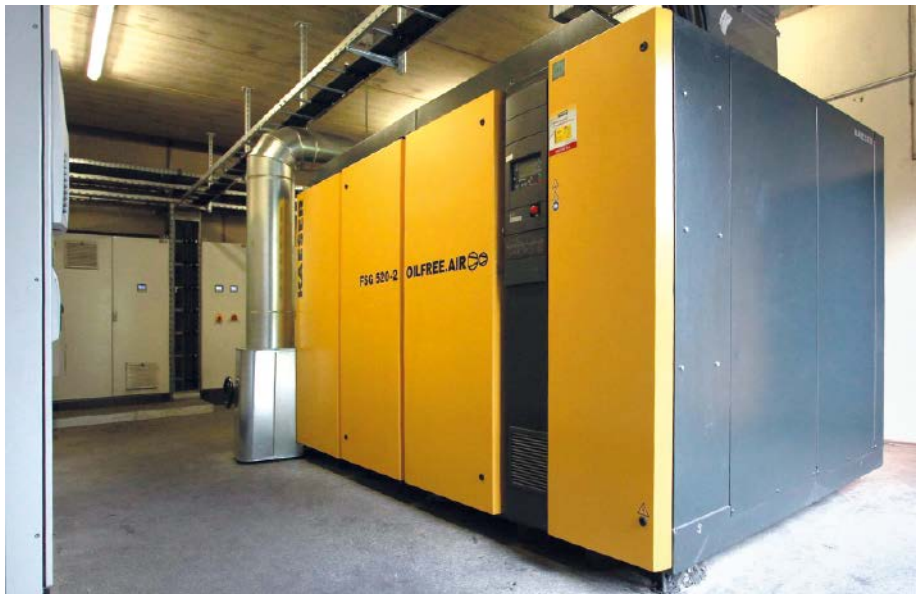
Der Kompressor mit Austrittstemperatur von 240 °C steigert die Effizienz der gesamten Anlage.
