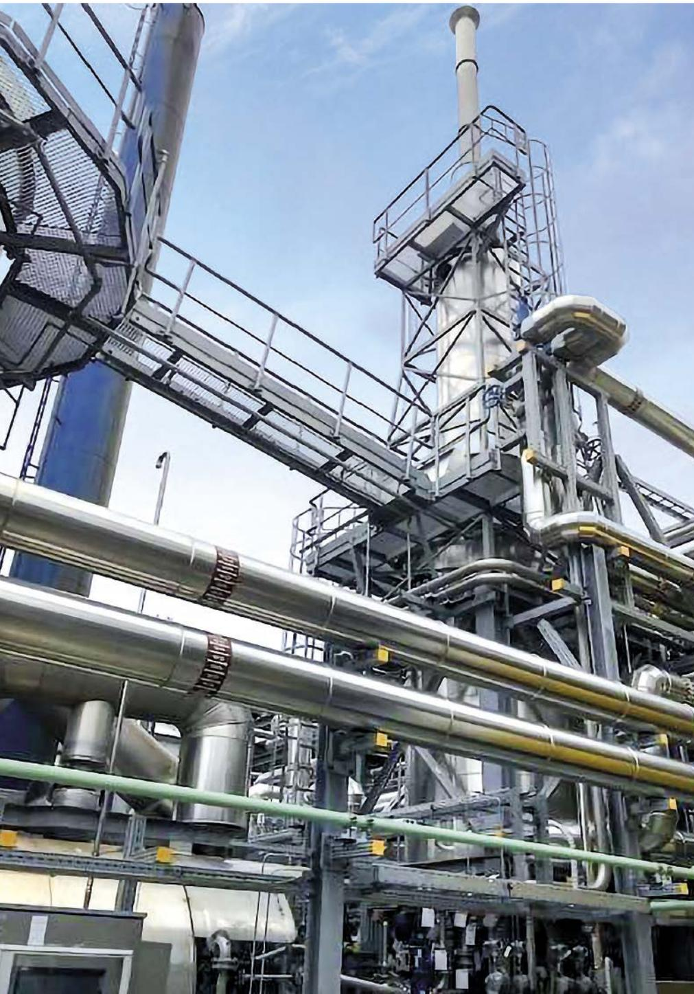
Abb. 1: Da die Leistung der im Jahr 2007 in einer Raffinerie installierten Wärmeträgerölanlage der Classen Apparatebau Wiesloch (CAW) nicht mehr ausreichte, wurde das Unternehmen beauftragt, eine zweite Anlage zu installieren und beide in ein gemeinsames Gesamthydrauliksystem mit allen Hochtemperatur-Verbrauchern und einem gemeinsamen Ausdehnungssystem zu integrieren.
