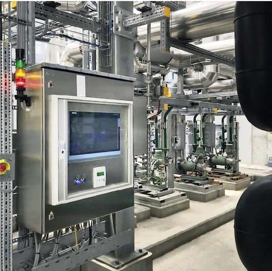
Abb. 2: In der neuen Anlage werden unter anderem auch zwei Non-Seal Spaltröhrenmotorpumpen von Lewa eingesetzt. Ein Aggregat fungiert als Primärpumpe für die Zwangsdurchströmung des neu gelieferten Wärmeträgererhitzers.
