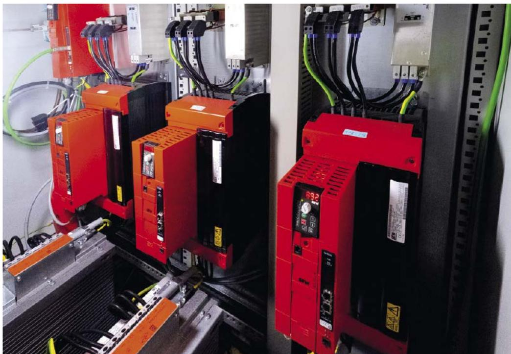
Abb.4.: Drei Frequenzumrichter der Baureihe Movitrac B versorgen drei Gruppenantriebe für 18 Spinnpumpen.
