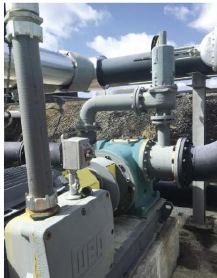
**Abb. 2: Die Schraubenspindelpumpe sorgt im Ölterminal für Effizienz und Zuverlässigkeit.**
