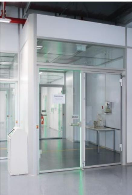
**Abb. 5: Reinraumtauglich angelieferte Teile werden über raumgroße Materialschleusen in den Reinraum eingeschleust**
