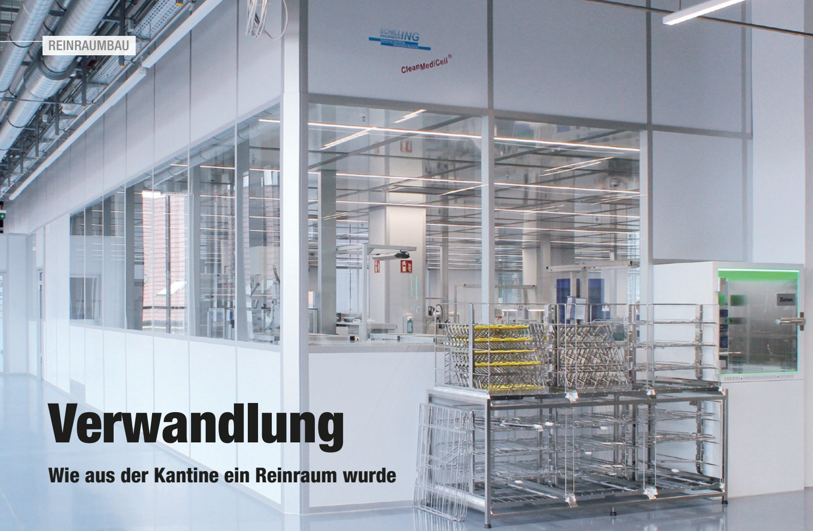
Abb. 1: Der Reinraum CleanMediCell in der Außenansicht. Rechts eine Dokumentenschleuse mit LED-Beleuchtung.
