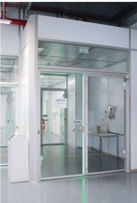
Abb. 3: Reinraumtauglich angelieferte Teile werden über raumgroße Materialschleusen in den Reinraum eingeschleust
