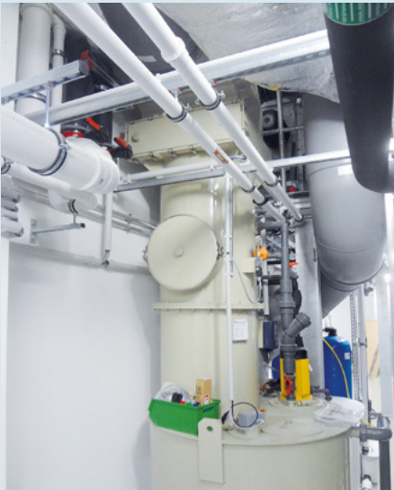
Abb. 1: Die Reinigung der schadstoffbehafteten Prozessabluft aus den Laborprozessen erfolgt in einem vertikalen Abluftwäscher Airtop KS-V mit Tropfenabscheider Zyklotop der Firma Richard Tscherwitschke.
