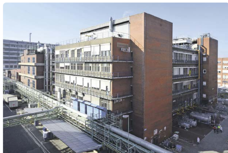
In den Ausbau des Zentralen Technikum Organisch (ZeTO) investierte Lanxess 2015 rund 60 Mio. EUR.
