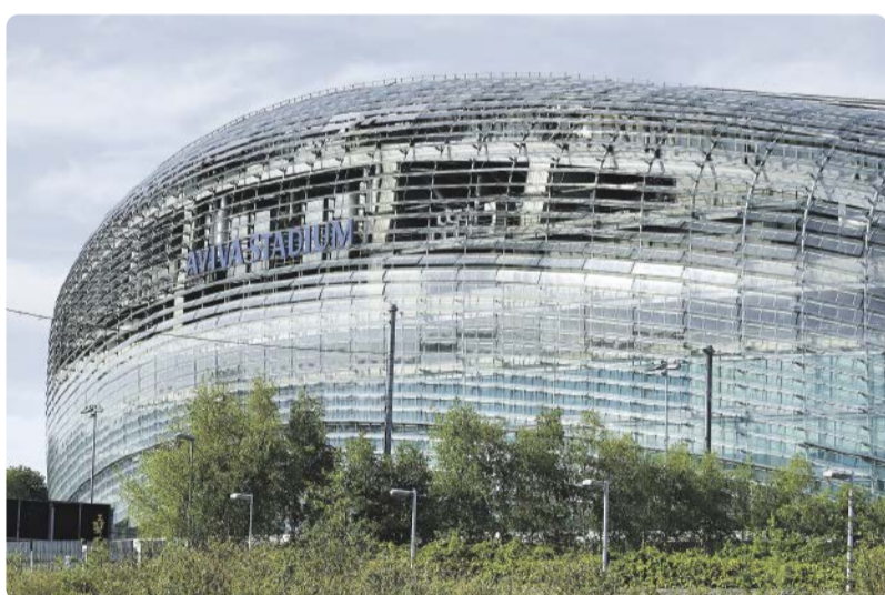
Das Aviva-Stadion in Dublin nutzt die ausgezeichnete Kaltbiegbarkeit monolithischer Lexan-Exell-PC-Platten für ein spektakuläres Fassadendesign.
