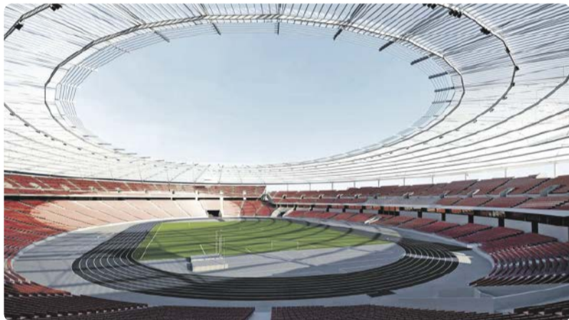
Lexan-Thermoclear-Platten mit X-Struktur verleihen dem freihängenden Dach des Stadions in Śląski Chorzów (Polen) eine große Steifigkeit bei geringem Gewicht.
