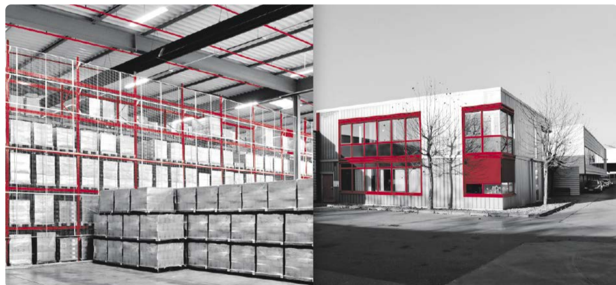
Loxxess: Gefahrstofflager in Neuburg
