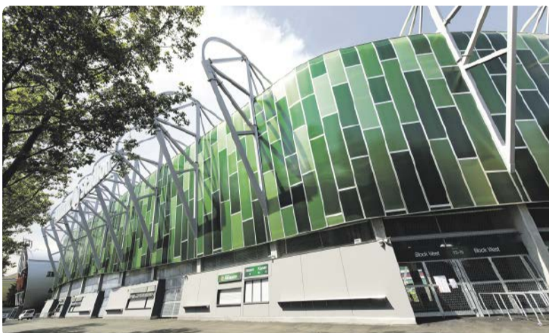
Polycarbonatplatten in vier verschiedenen Grüntönen spiegeln bei der Allianz Arena in Wien die Vereinsfarben des Clubs Rapid Wien.
