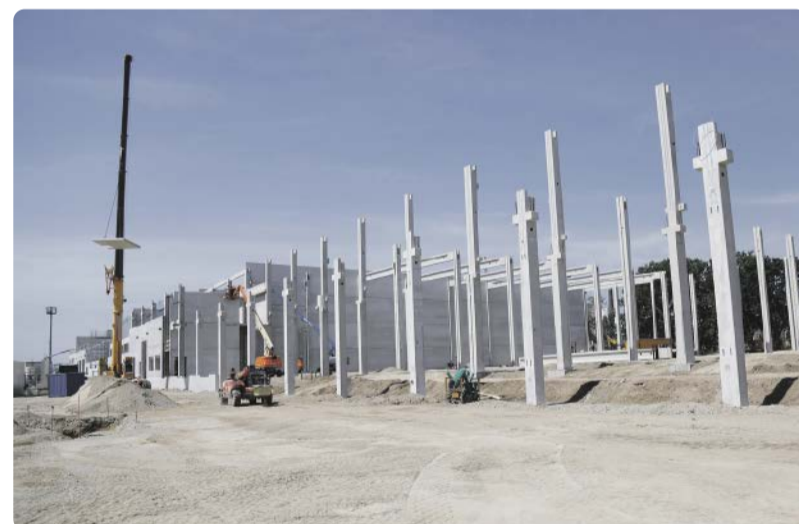
Blick auf die Baustelle: Das neue Gefahrstofflager im Industriepark Höchst wächst rasch in die Höhe.
