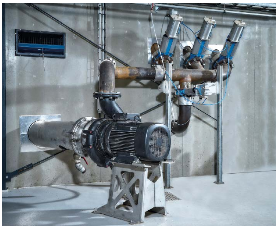
Abb.3: Durch eine kontinuierliche Gaseinspeisung wird eine dreidimensionale Rührwirkung erzielt, die eine konstante und optimale Zirkulation im Fermenter generiert, wodurch die Bildung von Schwimmschichten vermieden wird.
