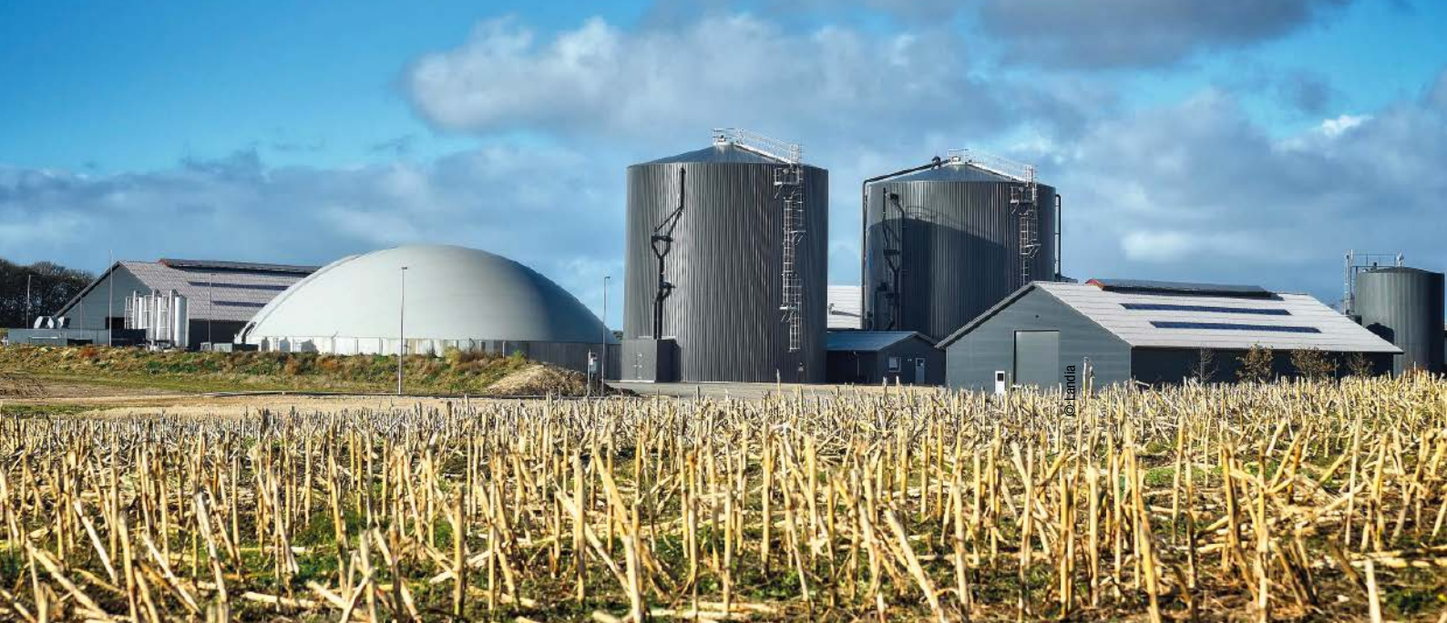
Abb. 1: Beim dänischen Landwirtschaftsbetrieb Rybjerggaard stellt eine Biogasanlage die Selbstversorgung sicher und ermöglicht Energieeinsparungen.
