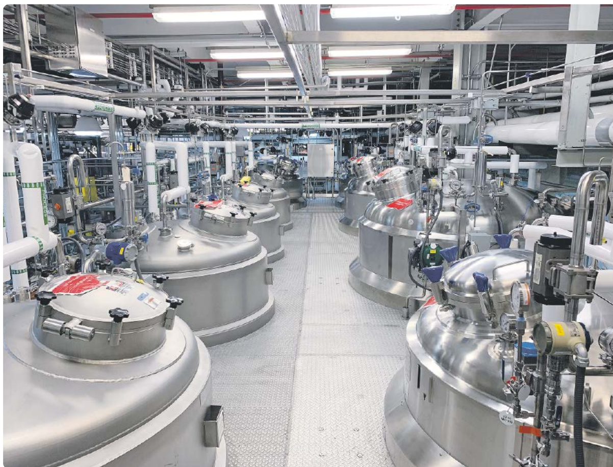
DPR Construction musste Herausforderungen am Standort bewältigen, als neue und bestehende Anlagen, darunter zusätzliche Filtrationsanlagen und größere Materialbehälter, unter beengten Platzverhältnissen eingebaut werden mussten.
