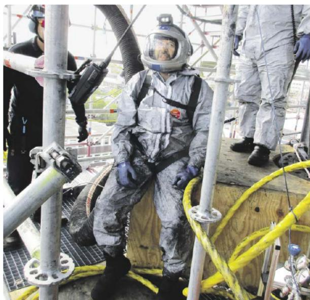
Das Life Support System verfügt über Luftzufuhr, Kommunikationseinheit und Sicherheitsgeschirr.
