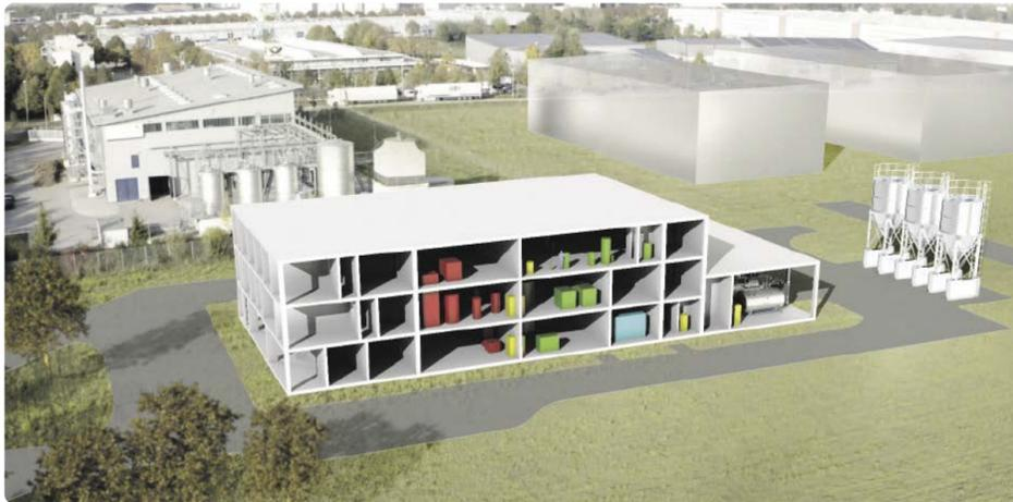
Die geplante Biocampus Multipilotanlage im Querschnitt: Der modulare Aufbau und physische Firewalls garantieren größtmögliche Flexibilität und Diskretion für künftige Kunden. Bereits realisiert ist die Sunliquid-Demoanlage von Clariant dahinter.
