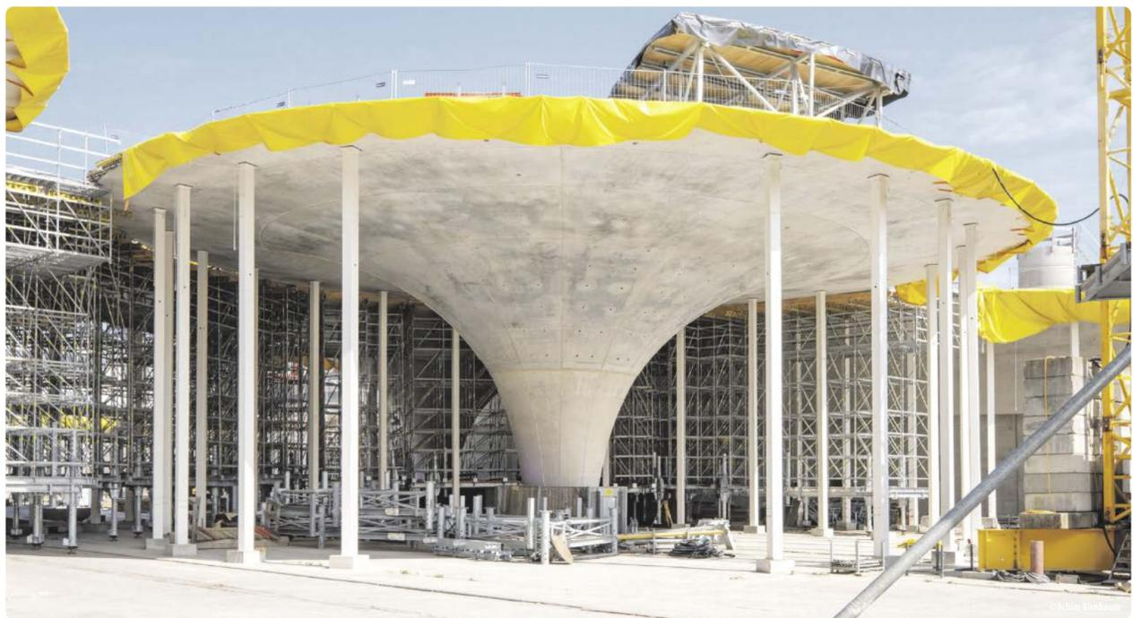
Kelchstützen bilden das architektonische Highlight des neuen Hauptbahnhofs in Stuttgart und setzen neue Maßstäbe in der Kombination von Statik und Design.
