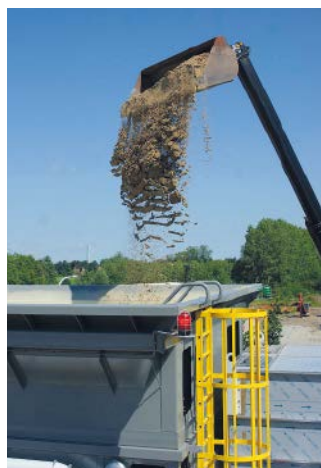
Abb. 2: Wenn das rote Signal leuchtet, verarbeitet der Wiegebunker noch Rohstoffe und der Kranführer muss warten. Dank der EVS-Funktion kann der Bediener das Signal sogar in der sehr hellen Umgebung Kenias eindeutig wahrnehmen.
