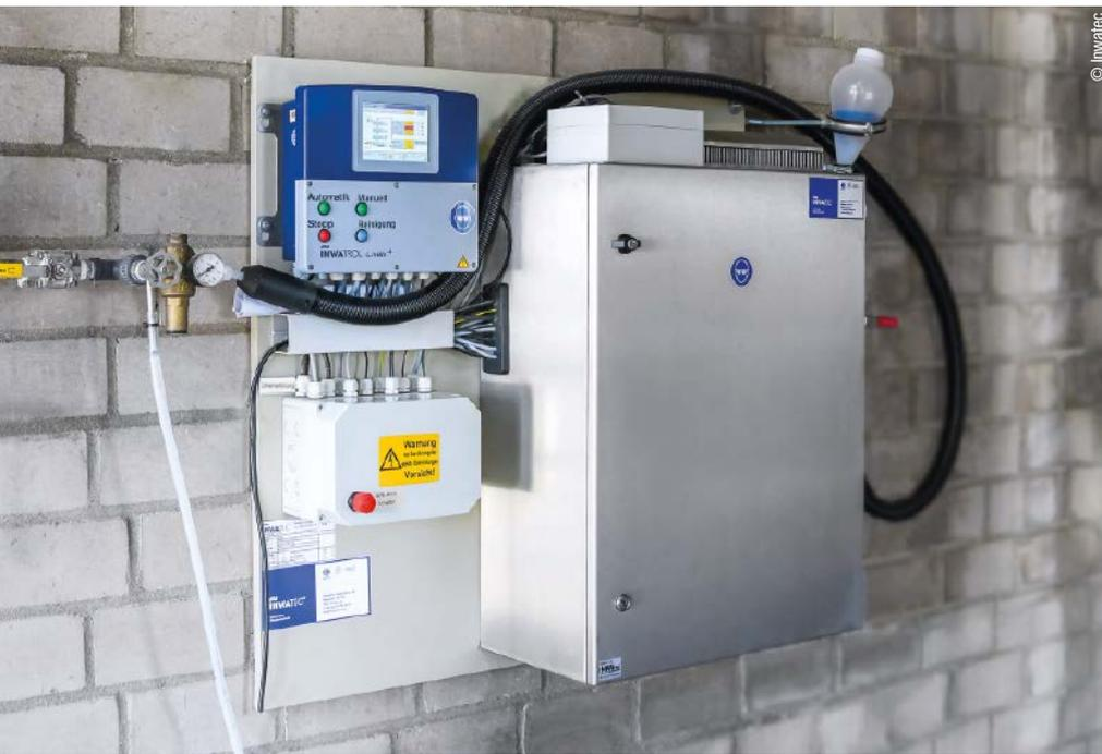
**Abb. 3:** Der Anlagenbetreiber kann gefahrlos und kontinuierlich die hygienische Wasserqualität ermitteln. Das Messgerät wird direkt an das technische Wassersystem mit automatischem und selbstdesinfizierendem Probeneinzug angeschlossen, einschließlich Selbstdesinfektion des in der Messzelle enthaltenen Wassers nach abgeschlossener Messung.
