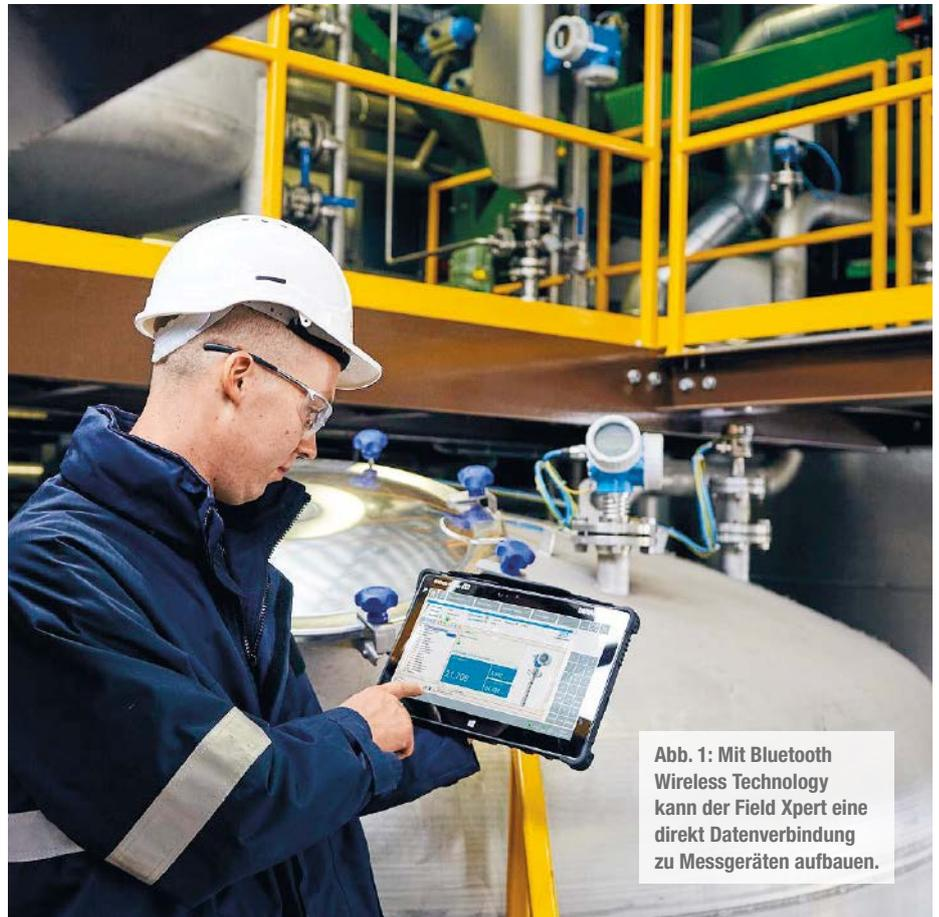
Abb. 1: Mit Bluetooth Wireless Technology kann der Field Xpert eine direkt Datenverbindung zu Messgeräten aufbauen.
