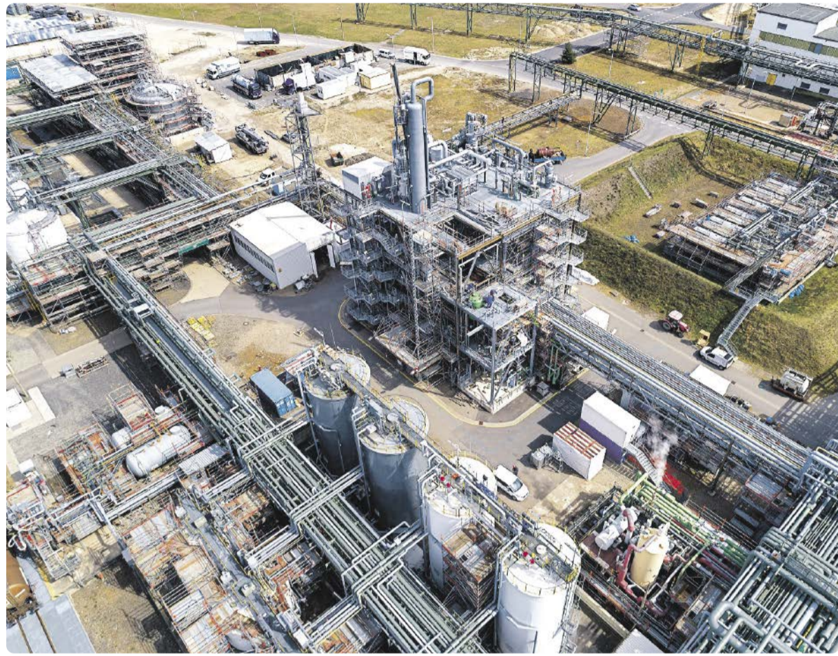
Die o-NT Produktion im BASF Werk Schwarzheide stand im Sommer 2020 für zehn Wochen still. In dieser Zeit wurden umfangreiche Rück-, Um- und Neuarbeiten durchgeführt. Ein Projekt, das gute Koordination zwischen Auftraggeber, Planern und Monteuren erforderte.
