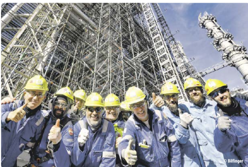
Bilfinger-Mitarbeiter in der Chemieanlage Shell Moerdijk
