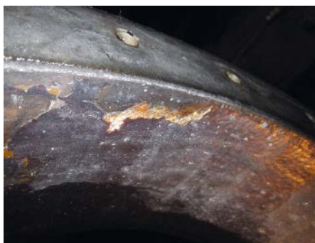
Abb. 1: Beschädigung am Mannlochhals eines Eindampfbehälters
