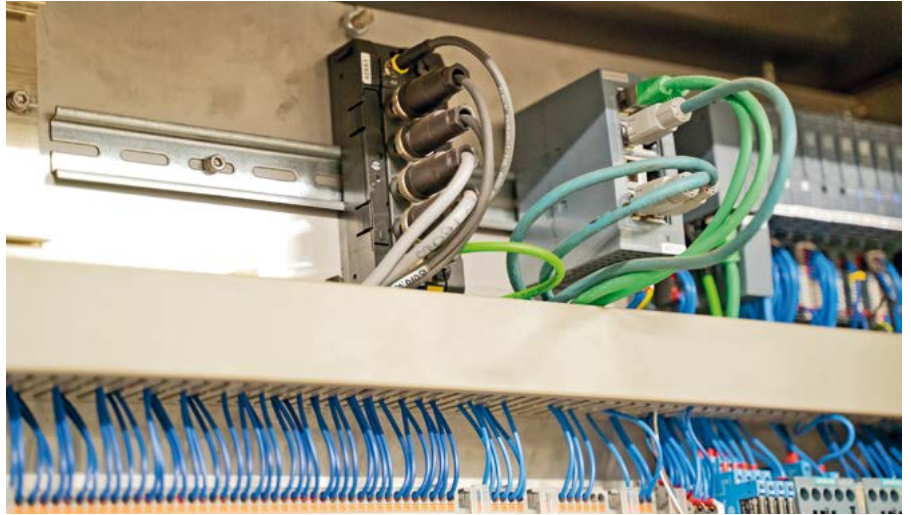
Schnelles I/O-Modul mit vier IO-Link-Eingängen: Das kompakte Multiprotokoll-Gerät dient als Schnittstelle zwischen Sensoren und SPS.
