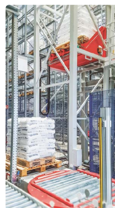
Automatisierte Einlagerung im neuen Hochregallager von Büfa Chemikalien
