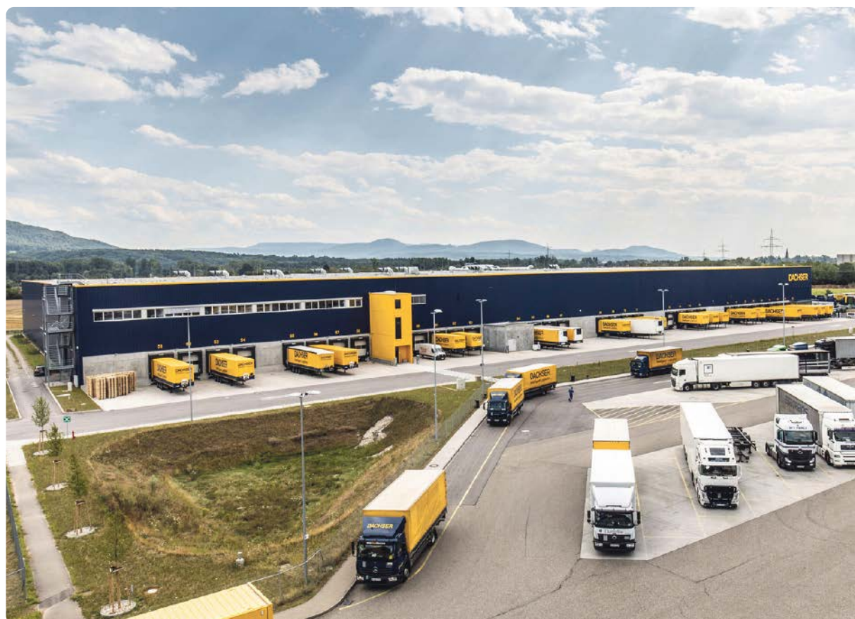
Der Dachser Standort Malsch bei Karlsruhe ist zentral gelegen mit großer Nähe zu Frankreich, einem der wichtigen Exportländer der deutschen Chemieindustrie. Dies war für das Logistikunternehmen einer der Gründe, am Logistikzentrum Karlsruhe ein neues Gefahrstofflager zu errichten
