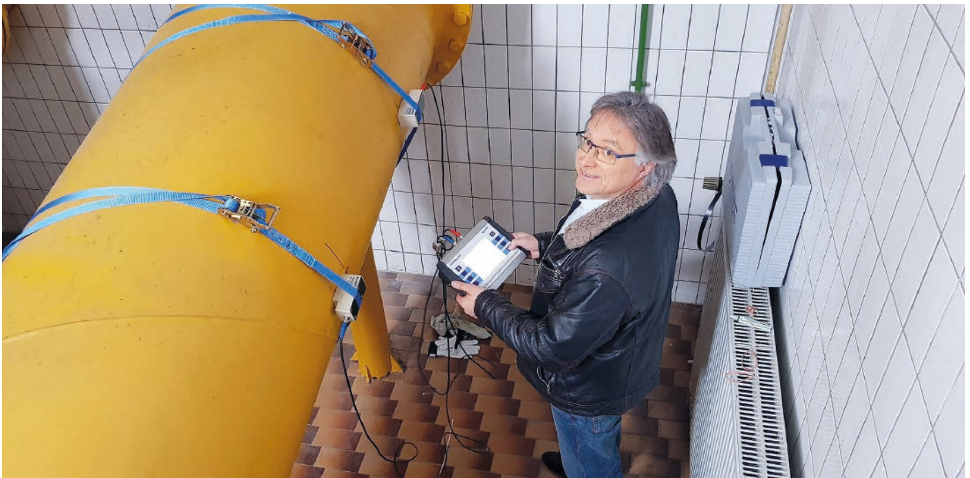
Abb. 6: Wickelfalzrohr, Rohabwasser, lackiert: Keine einfache Aufgabe, funktioniert nach der automatischen Signaloptimierung aber tadellos.
