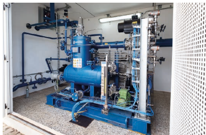
Abb. 1: Schraubenkompressoren von Aerzen verdichten das Biomethan für die Einspeisung ins örtliche Gasnetz
