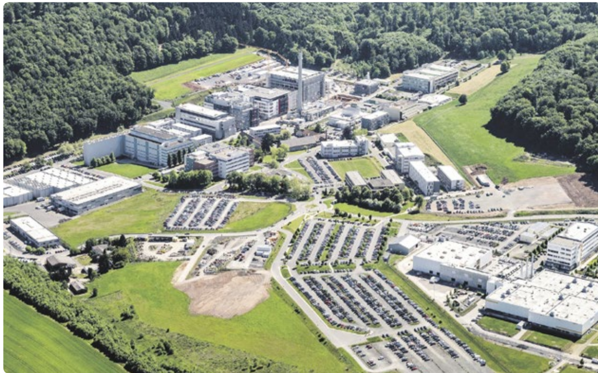
Pharmserv Technik bietet am Standort Behringwerke alle klassischen Leistungen im Bereich der technischen Dienstleistungen für die pharmazeutische Produktion bzw. das GxP-Umfeld
