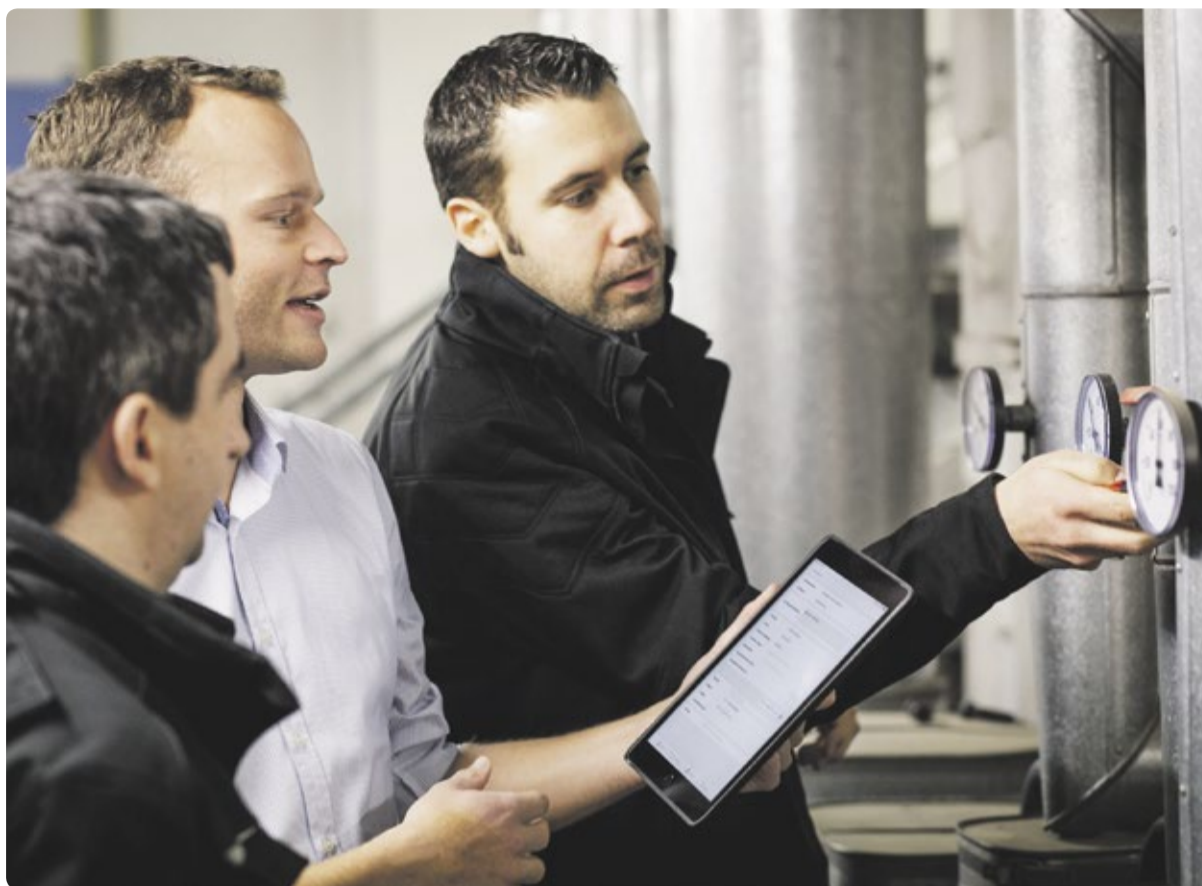
Gemeinsam mit Kollegen vom technischen Gebäudemanagement nimmt Ben Selle (Bildmitte) die Eckdaten der Anlagen auf, um sie im nächsten CAFM-Modul zu bündeln. Selle hat an der FH Münster eine Tischlerlehre gemacht, ein Bachelor- und Masterstudium im Immobilien- und Facility Management absolviert und arbeitet jetzt als Projektleiter im Dezernat Gebäudemanagement.
