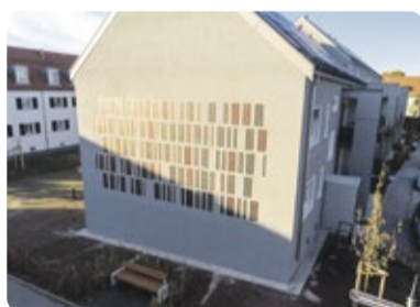
Multifunktionales Fassadensystem in der Putzebene des Gebäudes. Das OPV-System ergänzt als „aktive Komponente“ die Funktionalität des Wärmedämm-Verbundsystems.
