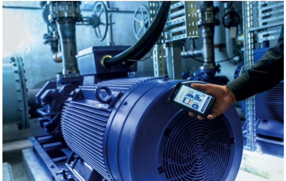
Abb. 1: Mit der Mobile-App „KSB Sonolyzer“ können Anwender in 20 Sekunden die Effizienz von unregelmäßig betriebenen Pumpen mit Asynchronmotoren analysieren.
