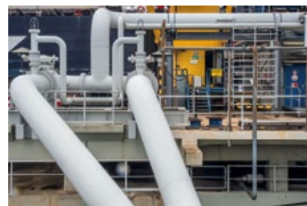
Abb. 4: Messstelle am Löschkopf 1 (über dem für die Installation aufgestellten Gerüst).
