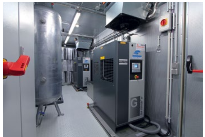
Abb. 2: Blick in den Container. Im Hintergrund die Schallschutzkulissen mit Pollenfilter, links die Speicherbehälter für Druckluft und Stickstoff.
