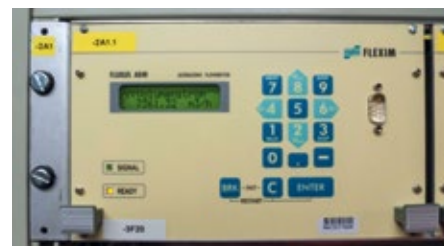
Abb. 3: Messumformer Fluxus F709 für den Einbau im 19“-Schaltschrank.
