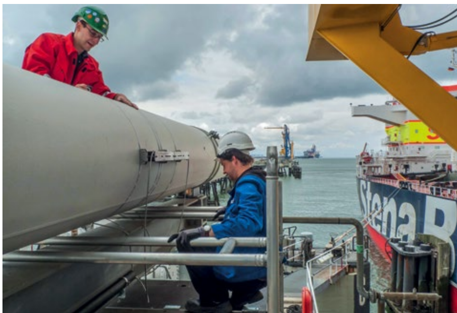
Abb. 2: Clamp-On-Ultraschallsensoren werden einfach außen auf der Rohrleitung aufgespannt, bei laufendem Betrieb.
