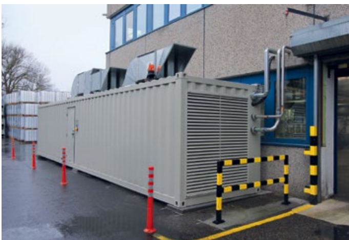
Abb. 1: Der Druckluft- und Stickstoff-Container wurde von Robert Baisch konzipiert und steht nun fest verrohrt, aber leicht umziehbar auf dem Werksgelände von CHT in Dußlingen.
