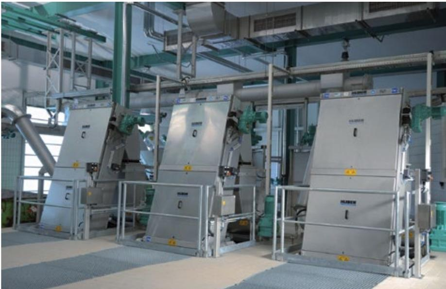
**Abb. 2:** In der Ab- und Prozesswasserreinigung gewährleisten robuste Raket aus Edelstahl Rostfrei die erforderliche Langlebigkeit.
