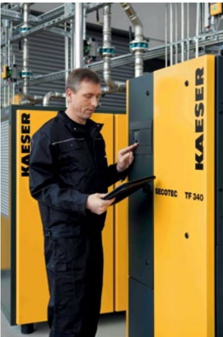
Abb. 2: Moderne Trocknungsverfahren, wie die des Secotec TF mit Latent-Speichersystem, sparen massiv Energiekosten und Platz.
