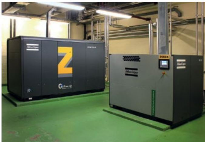
Abb. 2: Wärmerückgewinnung zum Nachrüsten: Die ER-Geräte (ER = „Energierückgewinnung“) von Atlas Copco, rechts im Bild, lassen sich an vorhandene Kompressoren anschließen. Im Bild hinten ein ölfrei verdichtender Kompressor des Typs ZR 315 VSD.
