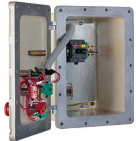
Abb. 3: EJB Ex d IIB+H<sub>2</sub> Steuerkasten mit eingebauten Schaltkomponenten
