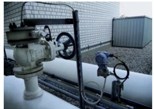
**Abb. 3:** Montagebeispiel: Der Ring wird mit einer Flanschverbindung zwischen dem Absperrventil und dem Messgerät angebracht.
