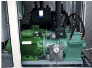
len Auslegung aller Anlagenkomponenten und der großen spezifischen Verdampfungsenthalpie von Ammoniak, die zu einer hohen Leistungszahl (EER) führt, weisen die GCM-Flüssigkeitskühler im Vergleich zu Wettbewerbsprodukten um bis zu ca. 25 % bessere Leistungszahlen auf.
