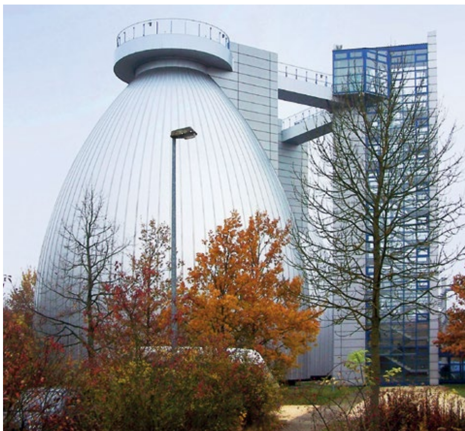
Abb. 2: Um den vorhandenen Faulraum im Faulturm (hier in der Kläranlage Landshut) optimal zu nutzen, werden aus dem Überschussschlamm 95 % des Wassers abgetrennt.
