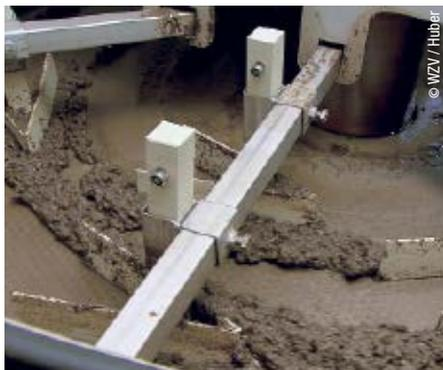
Abb. 2: Der im Bodenbereich des Eindickers angesammelte Schlamm wird durch Schilde aus nichtrostendem Edelstahl abgezogen und über Edelstahlrohre zur nächsten Behandlungsstation befördert.
