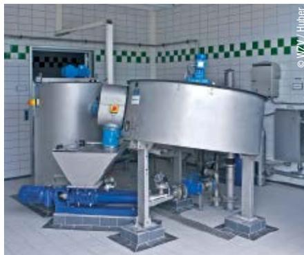
Abb. 3: Scheibeneindicker sind trotz ihrer kompakten Bauform sehr effizient. Edelstahlgehäuse kapseln die Anlagen komplett ein und tragen so zu einer sauberen Arbeitsumgebung bei.
