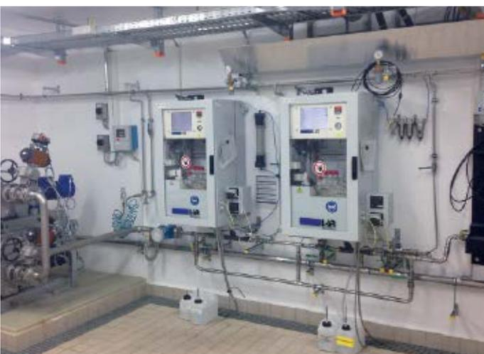
Abb. 2: Messraum – Online-Überwachung Oberflächenwasser
