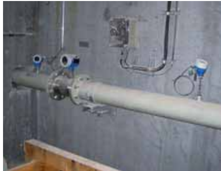
Abb. 2: Druck, Volumenstrom und Temperaturmessung zur pneumatischen Förderung
