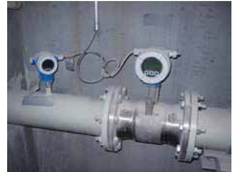
Abb. 3: Durchfluss- und Druckmessgerät mit einheitlichem 3-Tastenbedienkonzept
