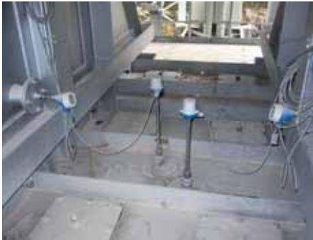
Abb. 1: Temperaturmessung am Überströmkanal des Doppelschachtofens
