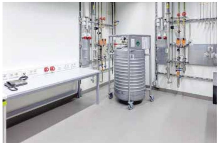
**Abb. 4:** Die Kautschukböden sind homogen und volumenleitfähig, ohne Adern, Fasern oder Fachse.
