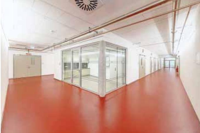
**Abb. 1:** Für störungsfreies Arbeiten in Reinräumen ist der Boden ein wesentlicher Faktor. Er muss robust, medienbeständig sowie elektrostatisch ableitend sein.
