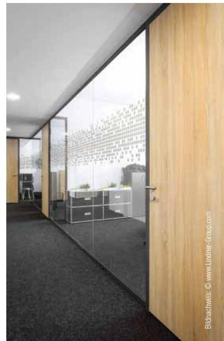
**Abb. 4: In den Büroräumen kam Cavopex mit durchgängigem, dunklem Textilbelag zum Einsatz, kombiniert mit hochwertigen Holztüren und Glastrennwänden Lindner Life 620.**
