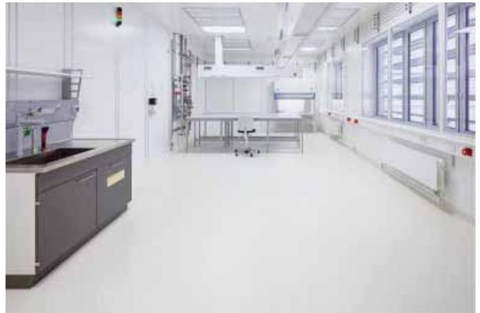
**Abb. 3:** Der in den Reinräumen im CHyN verlegte Belag noraplan sentica ed widersteht Kontamination, Chemikalien und Desinfektionsmitteln.
