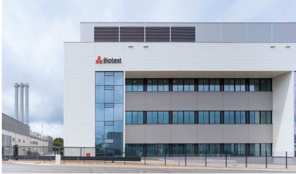
Abb. 8: Biotest investiert am Standort Dreieich mehr als 250 Mio. € in den Neubau eines Produktionsgebäudes. Dies soll die Kapazität mehr als verdoppeln.
