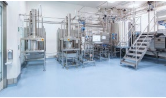
Abb. 7: Bei Beschädigungen ist die Instandhaltung anwenderfreundlich, ein Austausch einzelner Fliesen ist möglich.
