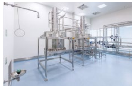
Abb. 2: Im Gebäude wurde der Boden norament grano verlegt – in den Reinräumen in der elektrostatisc ableitenden Variante.
