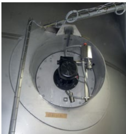
Abb. 1: Damit sich keine Ablagerungen bilden, wird der Tankinhalt mit einem effizienten und robusten Landia-Rührwerk in Bewegung gehalten.
