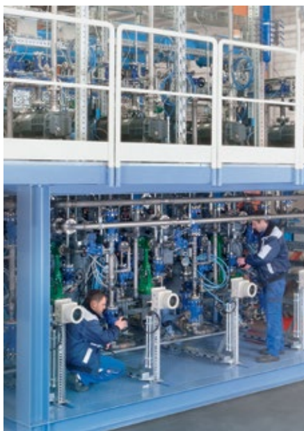
Abb. 2: Vakuumsysteme können aus vielen einzelnen Vakuumpumpen bestehen. Umso wichtiger ist es, den Stromverbrauch jeder einzelnen Pumpe genau zu kennen.
