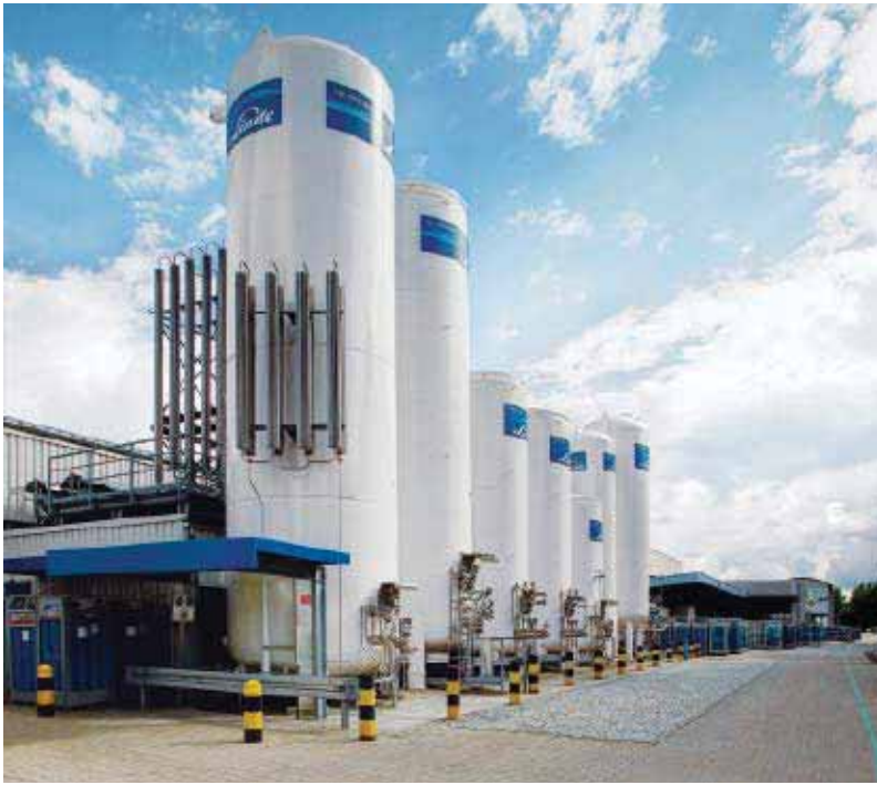
Abb. 6: Die komplett aus entmagnetisiertem Edelstahl Rostfrei gefertigten Kryobehälter haben ein Fassungsvermögen von bis zu 41.000 L
