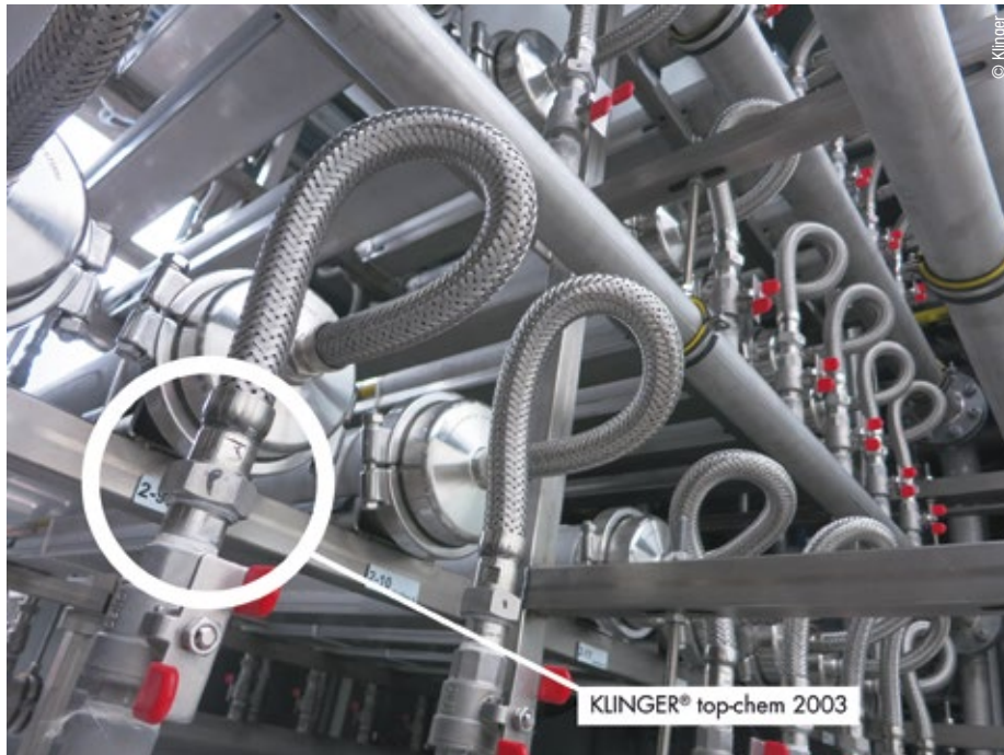
Abb. 1: Innenansicht eines Containers einer Biogasanlage
