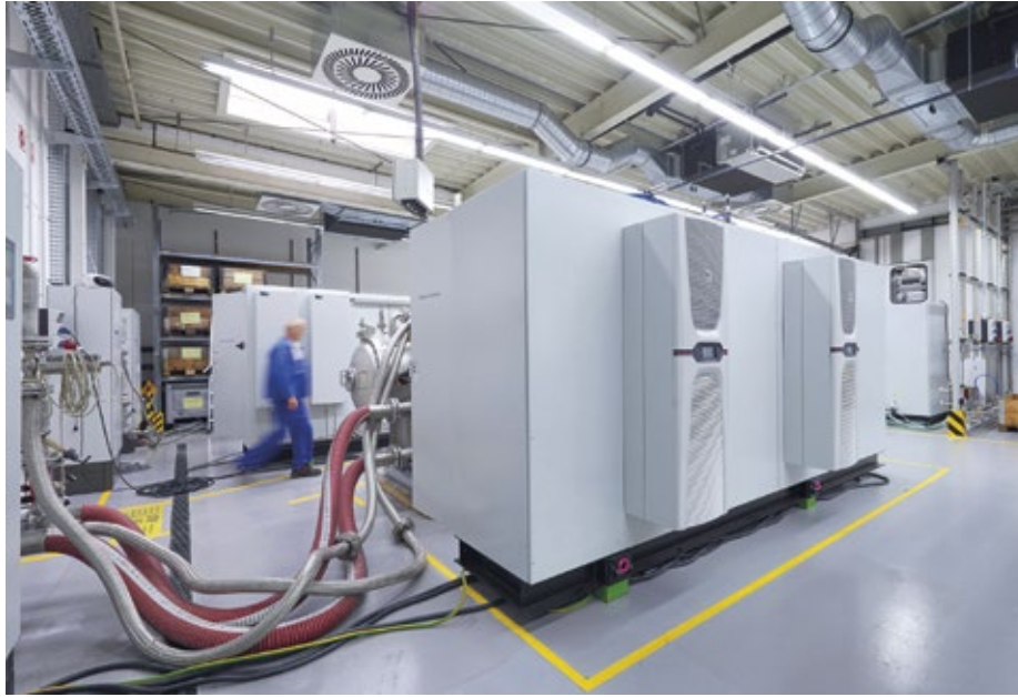
Abb. 2: Um eine Temperatur von maximal 35 °C in den Schaltschrank zu erreichen, kommen zwei Kühlgeräte aus der neuen Serie Blue e + von Rittal mit jeweils 6 kW Kühlleistung zum Einsatz
