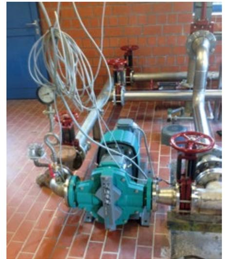
Abb.3 : Durch die Installation der T.Envi in einer münsterländischen Kläranlage sind hier Ölleckagen inzwischen ausgeschlossen, da die Pumpe völlig ohne Getriebeöl arbeitet.
