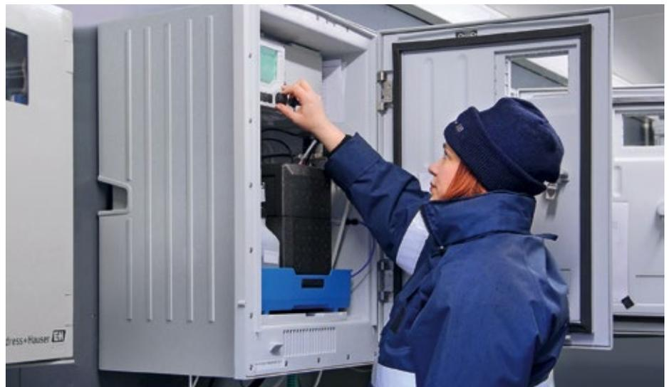
Abb. 2: Instrumente wie der Online-Analysator für Ammonium Liquiline System CA80AM liefern die Messwerte zur Automatisierung der Anlage.
