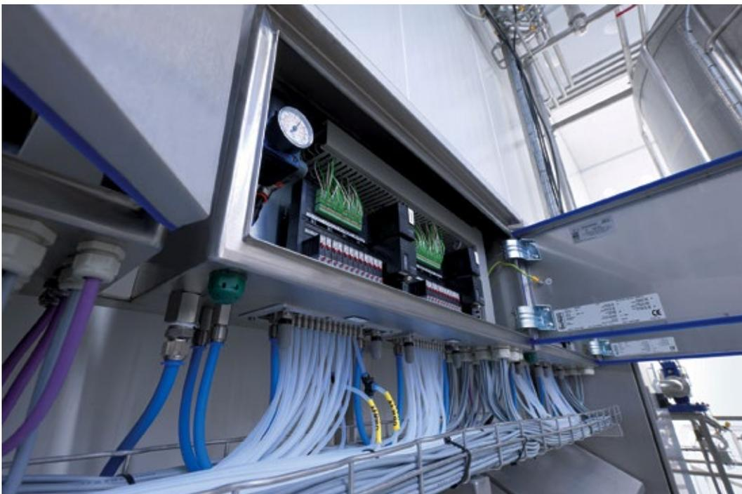
Abb.: Die modularen Schaltschranklösungen von Bürkert können direkt in der Anlage im unmittelbaren Prozessumfeld montiert werden
