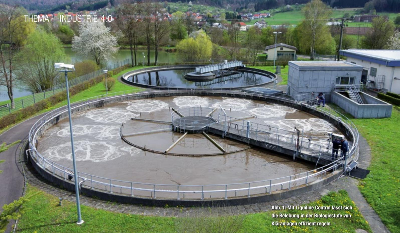
Abb. 1: Mit Liquiline Control lässt sich die Belebung in der Biologiestufe von Kläranlagen effizient regeln.
