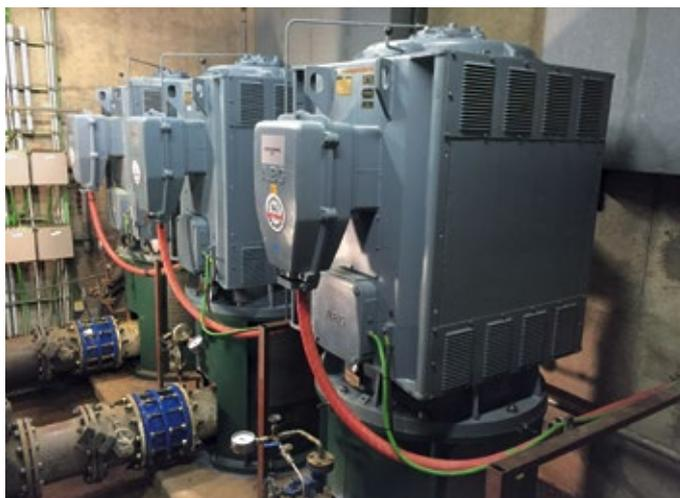
**Abb. 1: Pumpenanlage nach der Umrüstung: Die modernen Caprari-Pumpen arbeiten auch mit älteren Motoren.**
