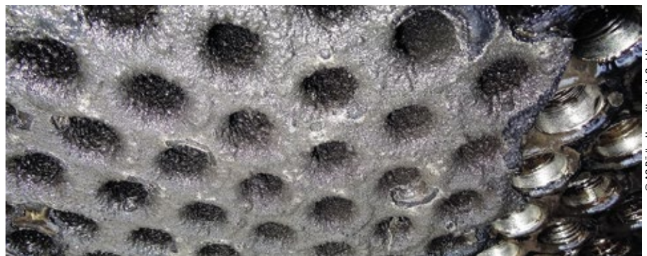
Abb.: Die vorliegenden harten Krusten und Verschlüsse konnten mit dem Verfahren, mit wirtschaftlichen Aufwand in kürzerer Zeit als üblich, vollständig entfernt werden.
