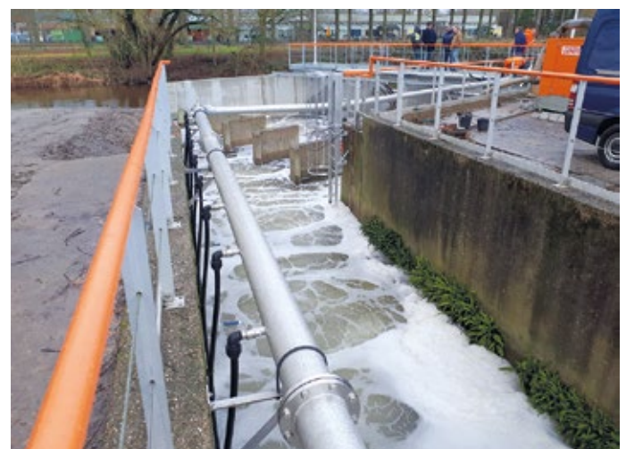
Abb. 6. Der Belüftungskanal der Kläranlage Eindhoven ist in Betrieb, da er die Sauerstoffqualität des Abwassers vor dem Wiedereintritt in die Dommel verbessert. Links: Blick auf den verstellbaren Damm am Ausgang des Belüftungskanals. Rechts: Ansicht des Belüftungskanals vom Einlass aus.
