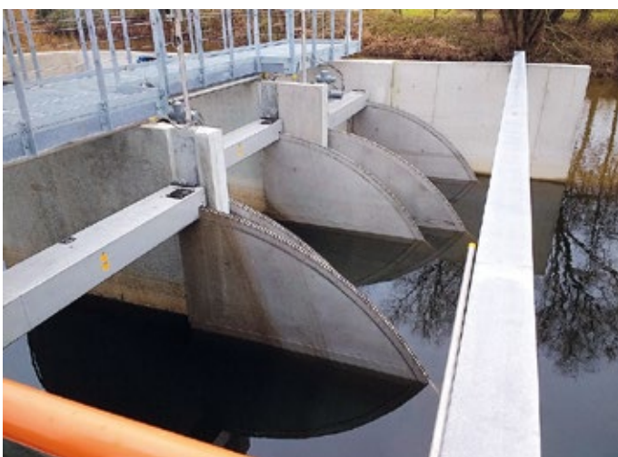
Abb. 6. Der Belüftungskanal der Kläranlage Eindhoven ist in Betrieb, da er die Sauerstoffqualität des Abwassers vor dem Wiedereintritt in die Dommel verbessert. Links: Blick auf den verstellbaren Damm am Ausgang des Belüftungskanals. Rechts: Ansicht des Belüftungskanals vom Einlass aus.
