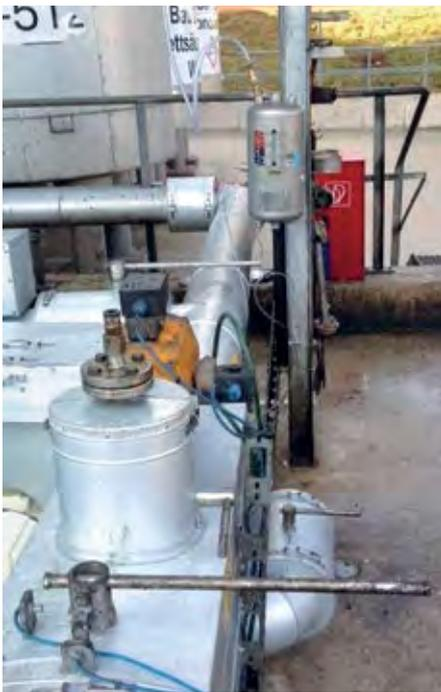
◀ **Abb. 4:** Fettsäuren sind nicht nur explosionsgefährlich, sondern auch ätzend. Für ihren Transport wurde eine Drehkolbenpumpe daher mit einer doppelwirkenden Dichtung mit Sperrdrucksystem ausgestattet. So werden Leckagen in die Umgebung zuverlässig verhindert.
