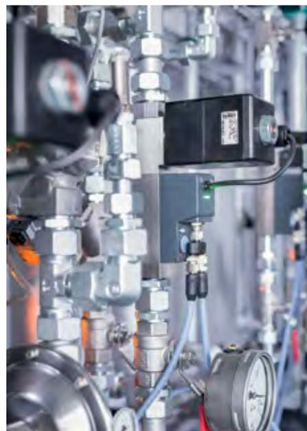
Abb. 3: Massendurchflussregler sorgen für eine optimale Reproduzierbarkeit der Gaszusammensetzung.
