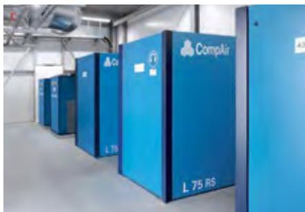
**Abb. 1: Druckluft-Containerstation mit drei drehzahlgeregelten Schraubenverdichtern und einer besonders energiesparenden Trocknerkombination.**
