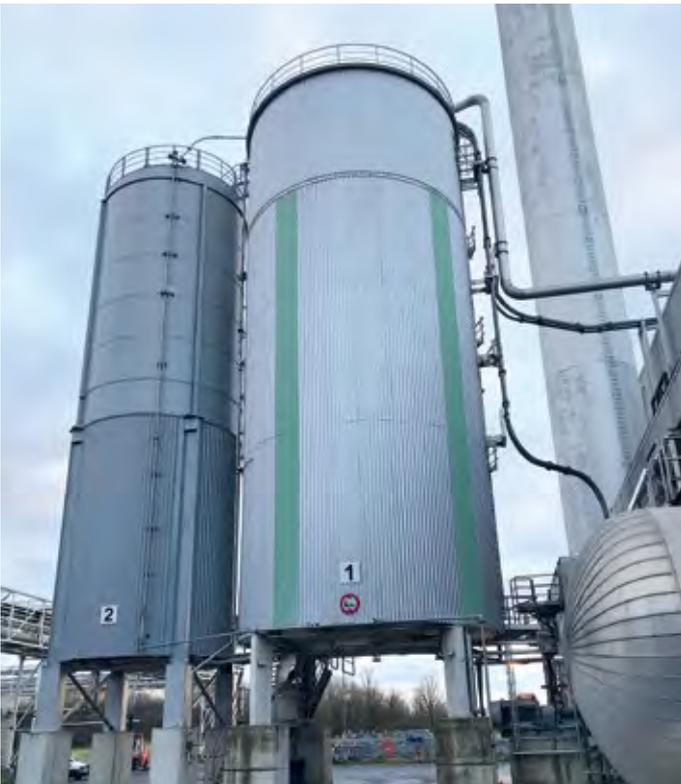
Abb. 1: Die Kesselasche wird im vorhandenen 600 m³ Silo gelagert, die Filterasche in einem neu errichteten 400 m³ Silo.
