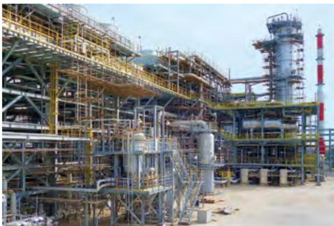
Abb. 2: Modulare Kerzenfilteranlage von BHS-Sonthofen in der Gasaufbereitungsanlage im Yolöten Gasfeld in Turkmenistan.
