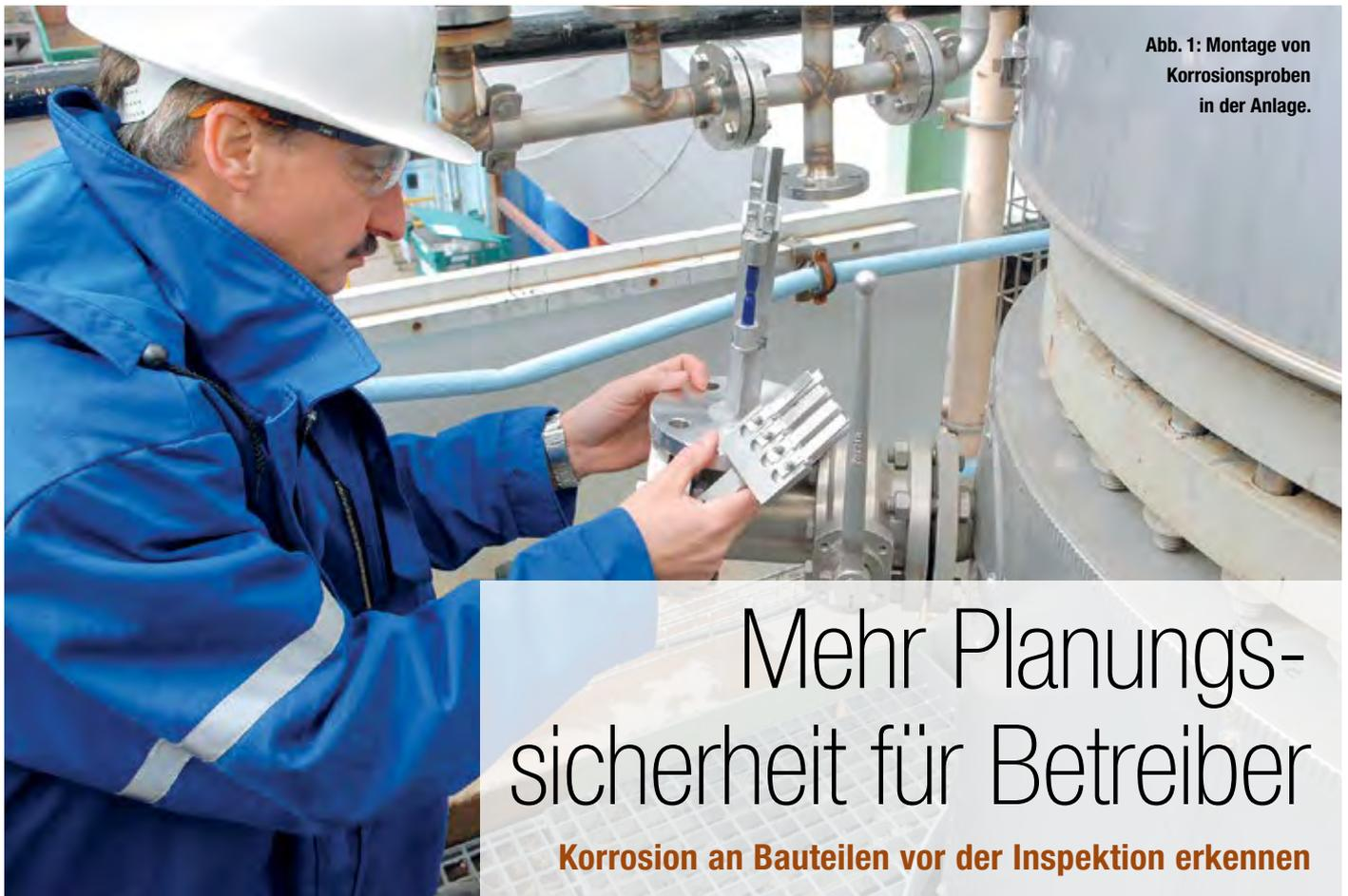
Abb. 1: Montage von Korrosionsproben in der Anlage.
