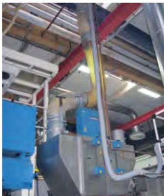
Abb. 2: Absaugung Extruder mit Elektrofilter aus Edelstahl (8000 m<sup>3</sup>/h)
