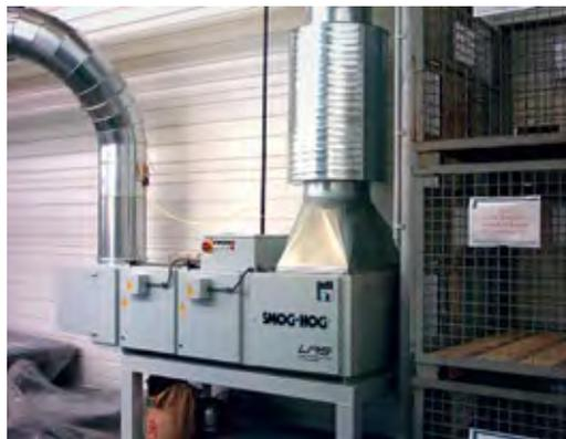
Abb. 3: Absaugung Ölrauch aus Wärmelinie
