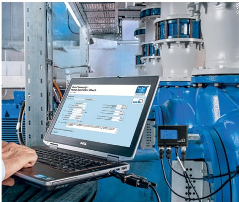
**Abb. 2: Mit der Dienstleistung Pump Operation Check und der Pumpenüberwachungseinheit PumpMeter lassen sich Lastprofile ermitteln.**
