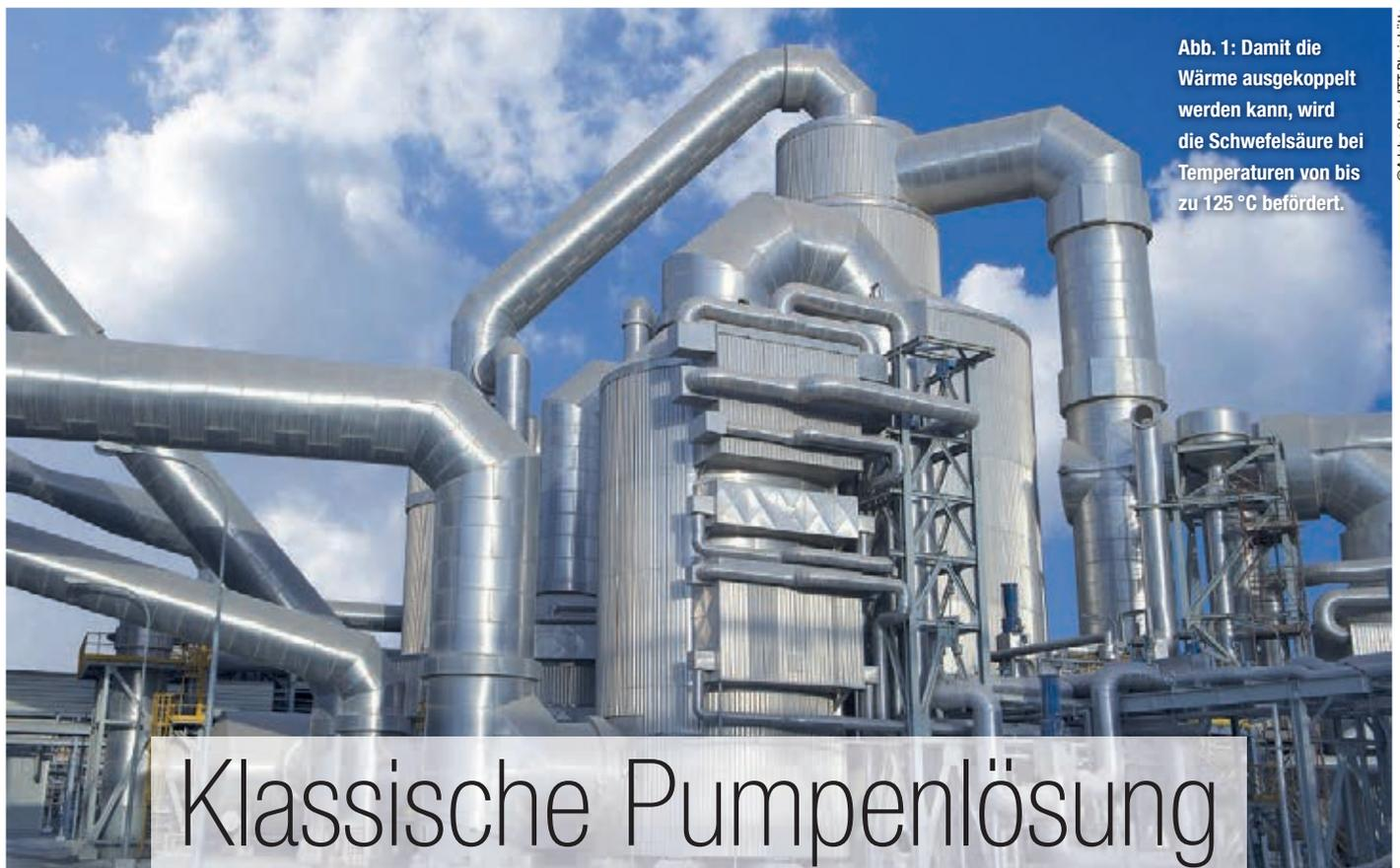
Abb. 1: Damit die Wärme ausgekoppelt werden kann, wird die Schwefelsäure bei Temperaturen von bis zu 125 °C befördert.
