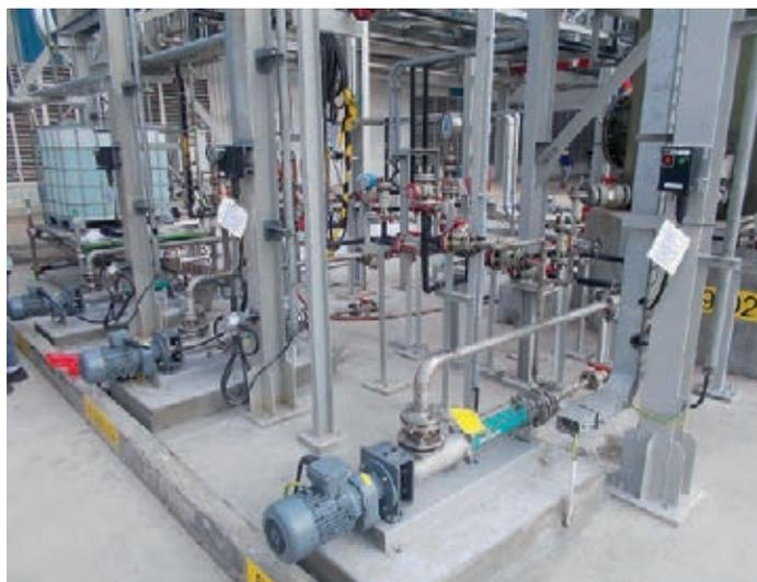
Abb. 2: Seit im Kautschukwerk in Java eine pulsationsarme Exzentrerschneckenpumpe zum Einsatz kommt, bereitet die Förderung des Trennmittels keine Probleme mehr.
