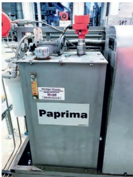
Abb. 2: Nur 50 cm groß sind die Behälter für das Hydrauliköl. Bisher gab es keine Möglichkeit, den Füllstand in solch kleinen Behältern exakt zu messen. Erst mit dem Vegapuls 64 ist dies möglich.
