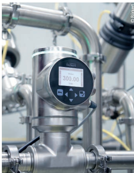
Abb.: Der SAW-Durchflussmesser liefert viele zusätzliche Fluidikparameter für einen zuverlässigen Prozess.
