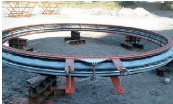
Abb. 2: Frenzelit-Design: Der vormontierte PTFE-Verbundkompensator, inklusive Rohrkonstruktion und Anschlussflansche, wird zum Einbau in die Entstaubungsanlage vorbereitet.
