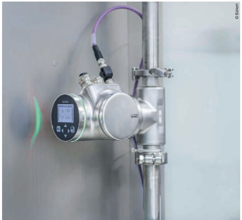
Abb.: Der SAW-Durchflussmesser ist flexibel einbaubar, erfüllt höchste Hygieneanforderungen und liefert zusätzliche Fluidik-Parameter für einen zuverlässigen Prozess.
