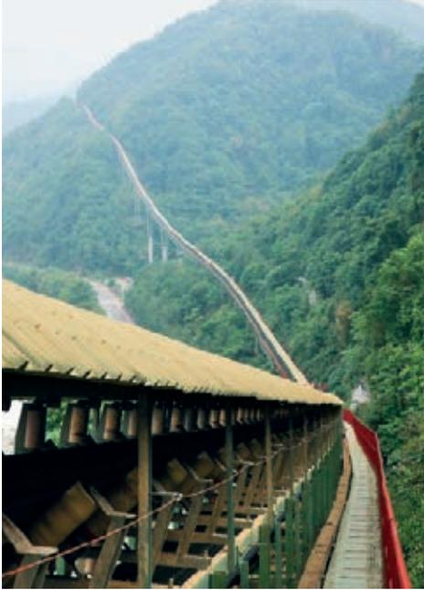
**Abb. 1: Der Muldenbeltförderer führt durch unwegsames Gebiet und über instabilen Untergrund.**
