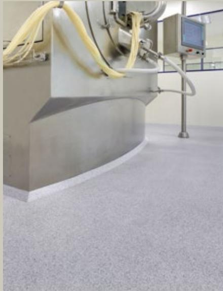
**Abb. 2:** Im Gegensatz zu vorkonfektionierten Platten- oder Bahnenprodukten passt sich der LW Pharma Terrazzo mühelos an Formen und Details vor Ort an.
