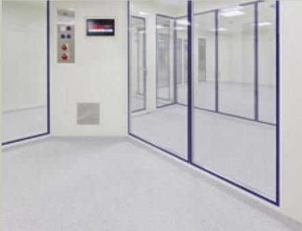
**Abb. 1:** Der Boden besteht aus einem Granulat, das direkt auf der Baustelle mit einem Bindemittel zu einem homogenen Mörtel vermischt und als eine einzige durchgehend fugenlose Bodenfläche aufgetragen wird.
