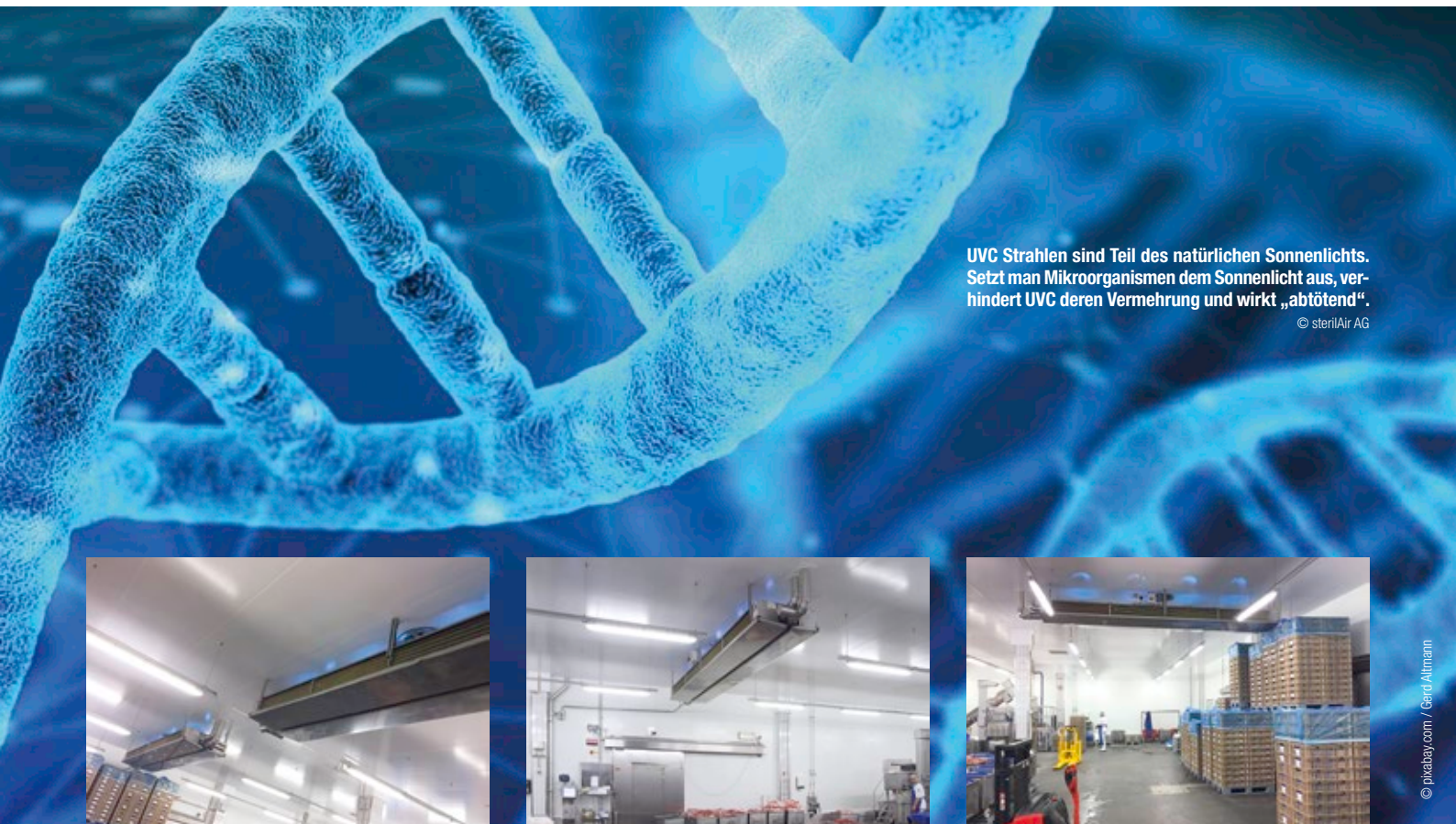
Abb. 1: Durch die installierten Entkeimungsgeräte kann die Bildung von Biofilm auf den Lamellen erfolgreich verhindert werden. Dadurch ist die austretende Luft nicht nur hygienisch sauber, auch die Reinigungsintervalle der Raumluftkühler konnten gestreckt werden.
