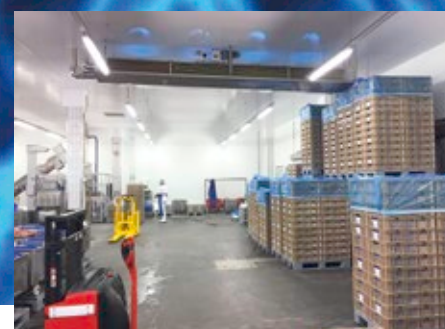
Abb. 3: In der Lebensmittelproduktion spielt die Hygiene eine große Rolle. Auch die Lamellen von Verdampfern müssen regelmäßig gereinigt werden, was einen hohen Arbeits- und Materialaufwand bedeutet.
