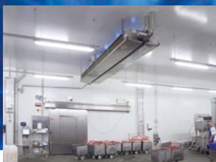
Abb. 2: Zum Einsatz kommen UVC-Entkeimungsgeräte aus der E-Serie der sterilAir AG. Das Schweizer Unternehmen arbeitet bereits seit mehr als zehn Jahren erfolgreich mit Micarna zusammen.
