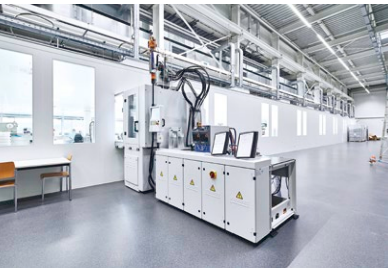
Abb. 1: Einige Komponenten werden mit Hilfe des Kunststoffspritzgussverfahrens hergestellt. Die Produktion im Reinraum hat jedoch den Nachteil, dass die Maschinen sehr viel Wärme entwickeln, was einen hohen Energieverbrauch durch die installierten Klimageräte nach sich zieht. Deshalb entwickelte bc-technology gemeinsam mit dem Spritzgussmaschinenhersteller ein Konzept, das es ermöglicht, die Maschinen in die Reinraumwand zu integrieren, ohne dass sich unerwünschte Partikel entwickeln können.
