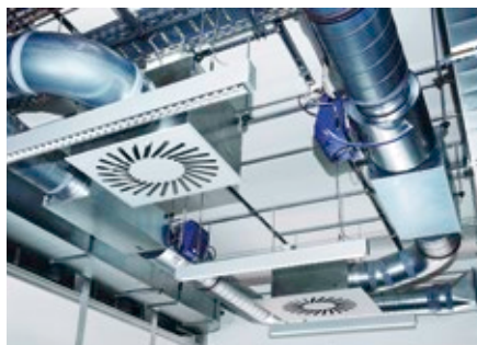
Abb. 4 a+b: Die neuen Antriebe Trox HPD zeichnen sich nicht nur durch eine Laufzeit von weniger als 3 s aus, sondern verfügen im Vergleich zur analogen Ausführung über eine 5-fach höhere Auflösung, was eine auf &lt; 0,1° präzise Positionierung des Drosselements erlaubt.
