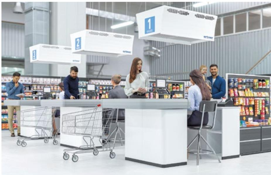
Personalschutz durch lüftungstechnischen Downstream
