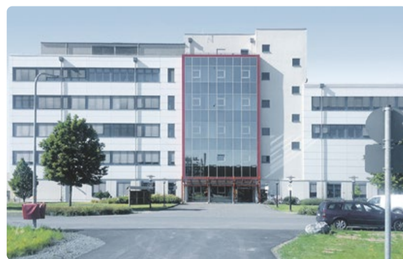
Beim Umbau des Laborgebäudes A 729 im Chemiapark Dormagen setzte der Bereich Verfahrensentwicklung der Bayer-Division Crop Science auf die Planungs- und Projektsteuerungsexpertise von Drees & Sommer.
