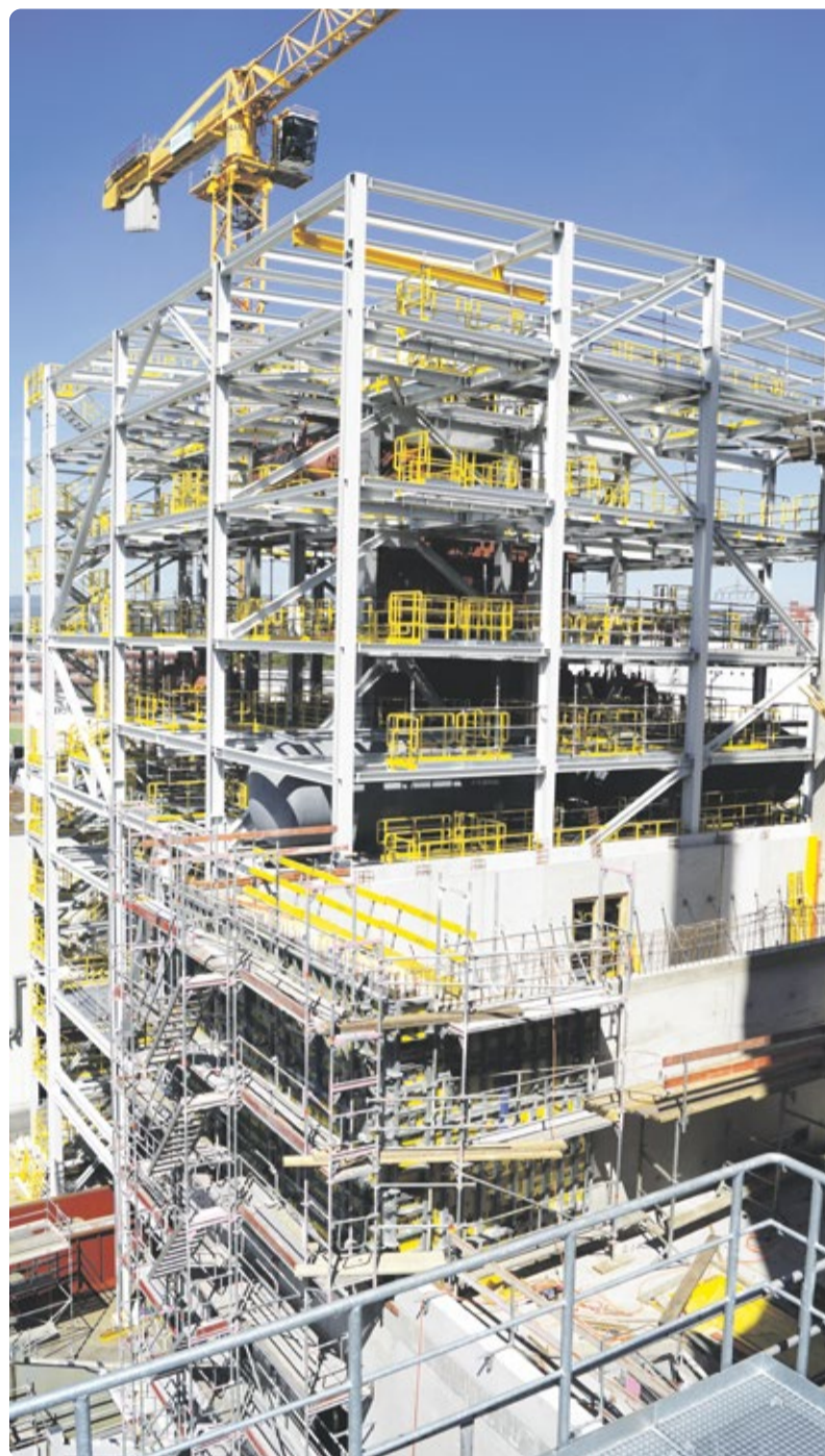
Die mehrgeschossige Stahlbaukonstruktion für das neue Kesselhaus des GuD-Kraftwerks im Industriepark mit Kopfbau und Treppenhaus aus Stahlbeton.
