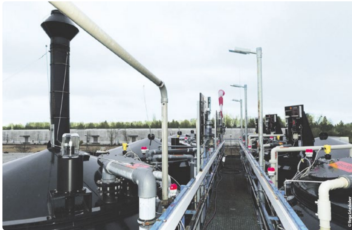
Kammer eines unterirdischen Lösemittel tanks bei Brenntag mit dem Radarsensor Vegapuls 64.
